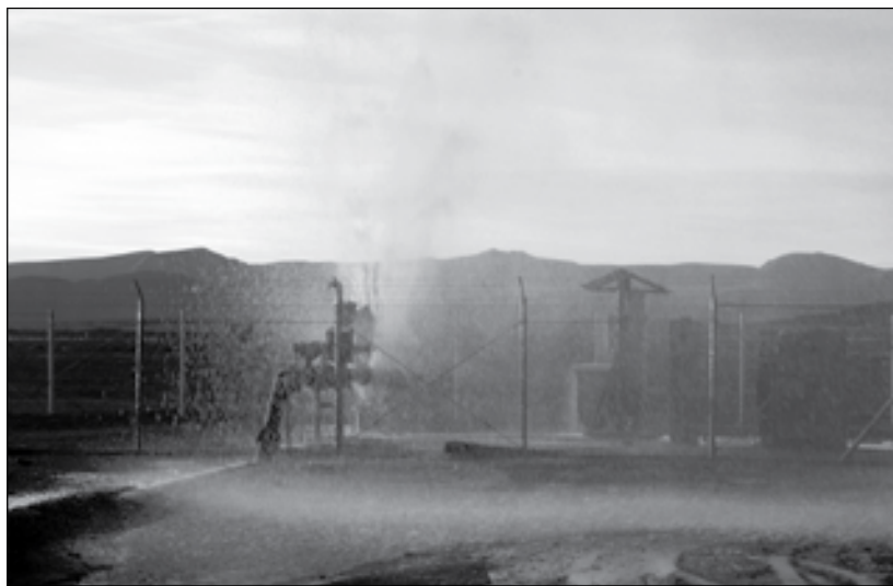
Pozo expulsando agua, Minera San Cristóbal.
